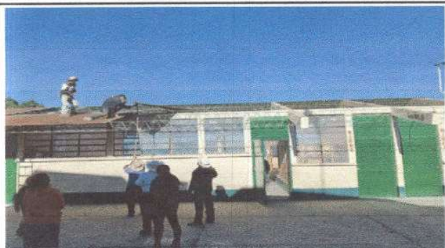
Foto 1: Proceso de la Sustitución de lámina para lámina troquelada Azulic Calibre 26
