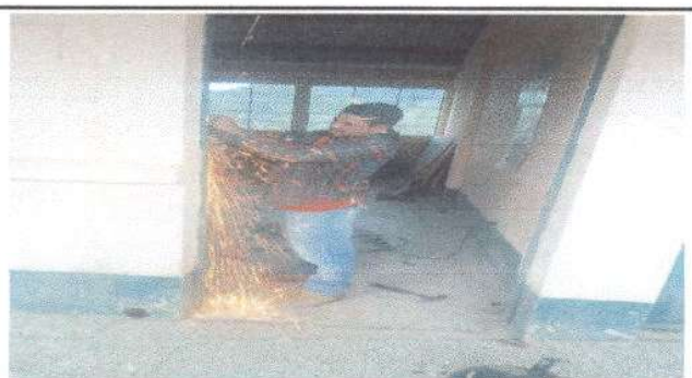
Foto 6: Sustitución de Puerta de metal de 1x2.93 mts. A Puerta de metal (Módulo 3 Aulas)
