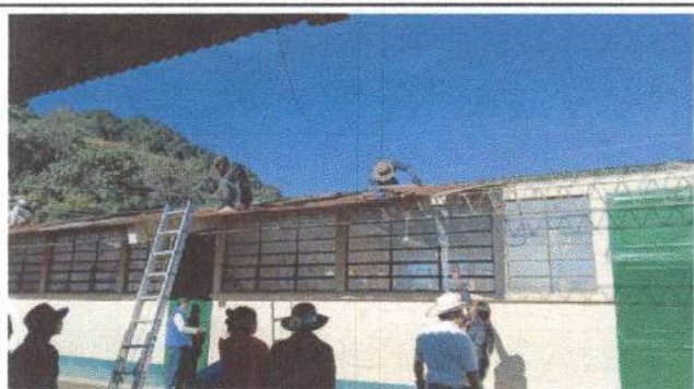
Foto 3: Proceso de Sustitución de Elementos de Fijación
