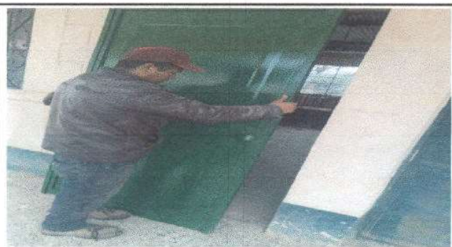
Foto 5: Sustitución de Puerta de metal de 1x2.93 mts. A Puerta de metal (Módulo 2 Aulas)
