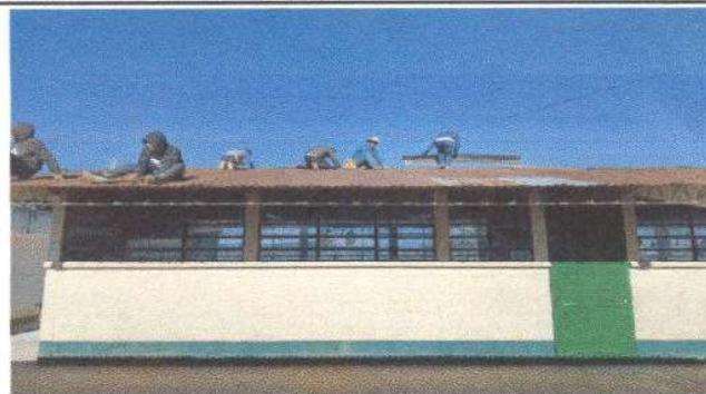
Foto 2: Realización de la Sustitución de Capote de lámina, para Capote de lámina Troquelada.
