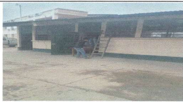
Foto 4: Sustitución de Puerta de metal de 1x2.93 mts. A Puerta de metal (Módulo 1 Aulas)
